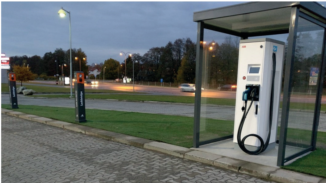
BILD 5. Snabbladdare med CCS & CHAdeMO kompletterad med Typ2 laddstolpar. Foto: Uppladdning.nu
