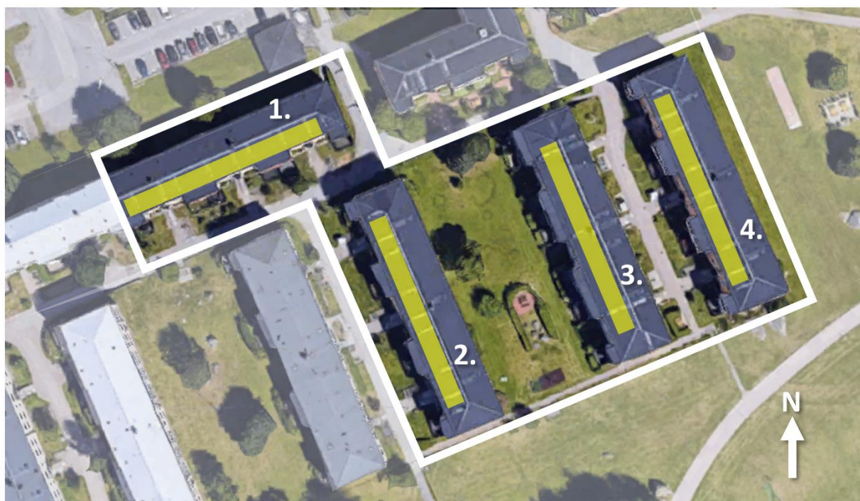
Figur 8: Tillgängliga takytor. Ytor markerade i mörkgrönt anses mest lämpliga för installation av solceller.
