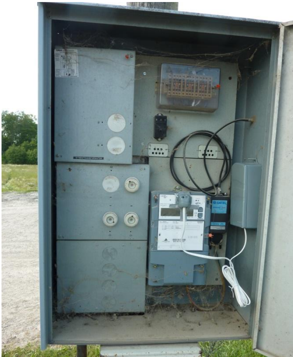
Figur 1. Mätöga och databox monterade i mätarskåp.
