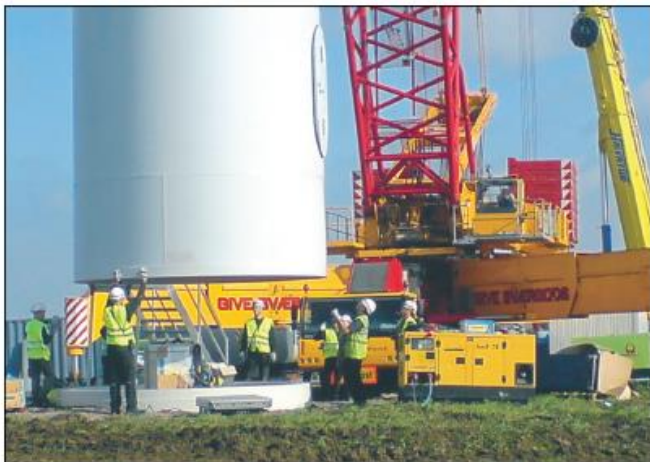
Flera man hjälper till att rikta in bottenröret. Bild: MATS WEINSSON
