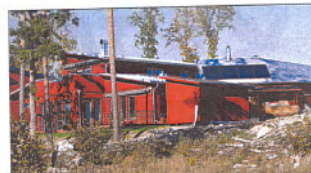
Bygget med vedbod. Tjocka väggar och rejäl isolering i golvet och tak kännetecknar lågenergihusen på Herrgårdssången. För att utnyttja solpanelerna på bästa sätt har de monterats upp i sydväst. Familjen Gärdstams solpaneler finansierades delvis med hjälp av bidrag från Länsstyrelsen.
