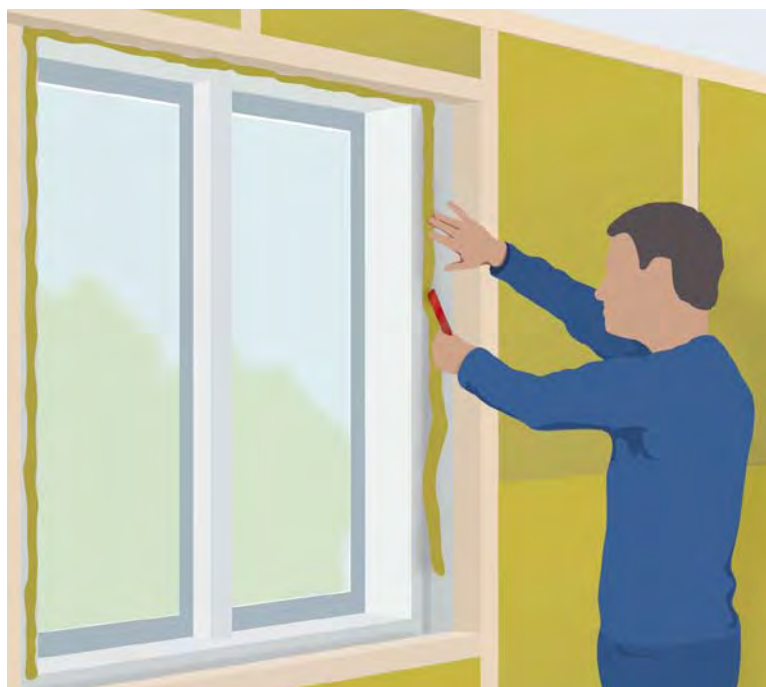
Drevning runt fönster minskar värmeförluster och drag.
