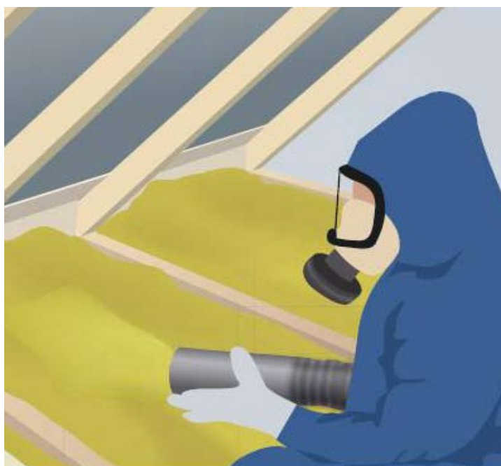
Ofta anlitas professionella lösullsentreprenörer för själva isoleringsarbetet.
