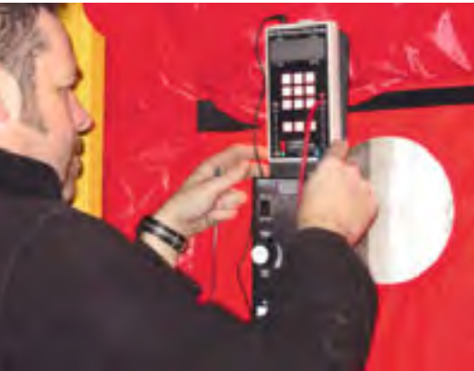
Husets lufttätthet mäts genom provtryck.
