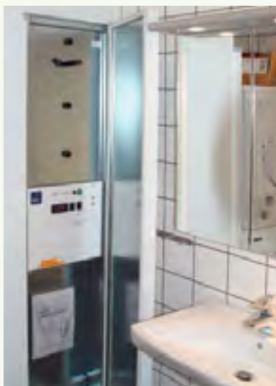
Ett FTX-aggregat tar inte stor plats. Det bör placeras lättillgängligt så att du enkelt kan byta filter.
