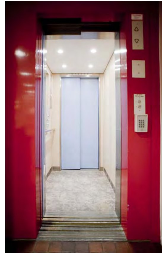
Figur 4.7. Hiss med närvarostyrd LED-belysning. Örebro Bostäder.
