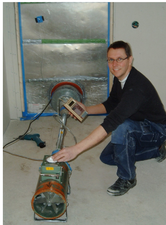
Provtryck i byggskedet
