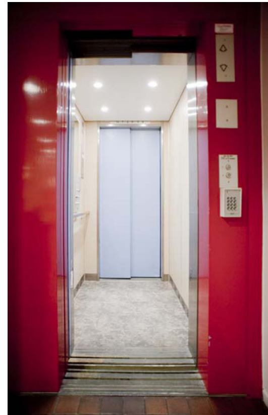
Figur 4.7. Hiss med närvarostyrd LED-belysning. Örebro Bostäder.
